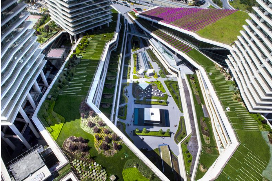
Şekil 7. Çatı bahçesi örneği
