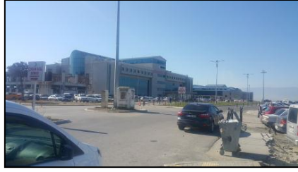
Şekil 4a. Hastane binası
